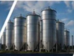
TANK & BORU HATLARI
